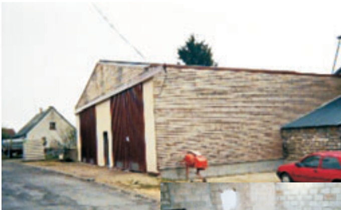
Vue extérieure de la chaufferie
